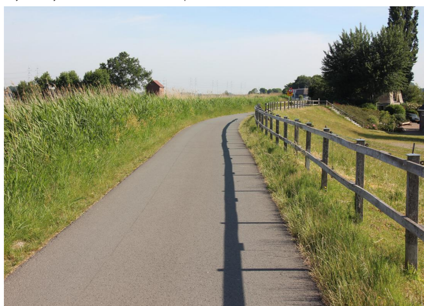
Hekwerk zuidelijk deel Rottedijk
